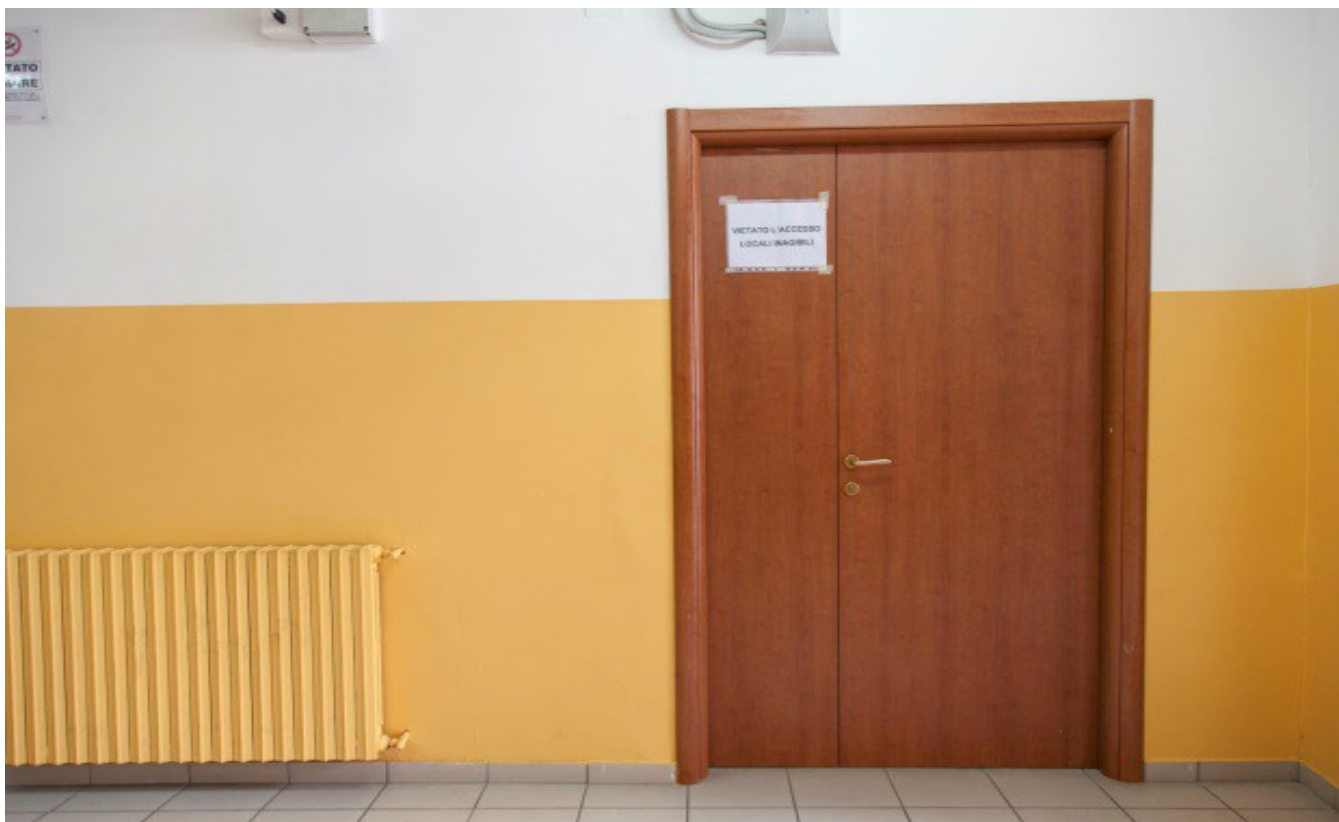
Corridoio «Scuole belle», due porte con la scritta «VIETATO L'ACCESSO LOCALI INAGIBILI»
