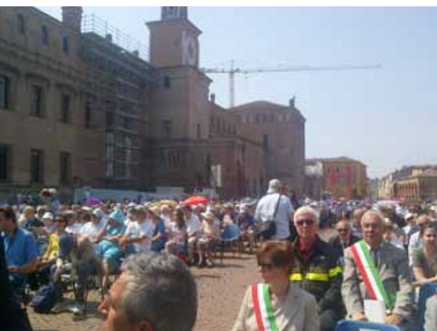
15 giugno 2013, in occasione della cerimonia di Beatificazione del Venerabile Servo di Dio Odoardo Focherini. Impalcature e gru nel fronte ovest di Palazzo Pio
